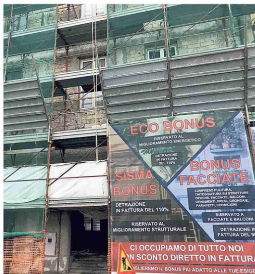
Boom dei cantieri in tutta Italia: ma i tempi sono lunghissimi
